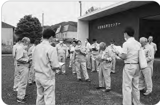
国富地区防災センター外構整備 配水設備、舗装、ゲートポール場造成工事
