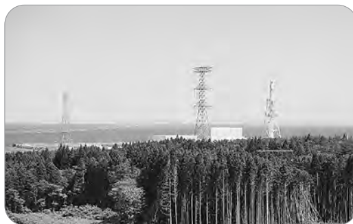
東通原子力発電所
