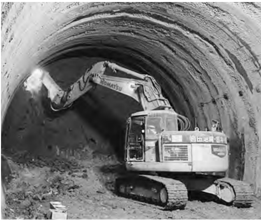
トンネルを掘削する様子
