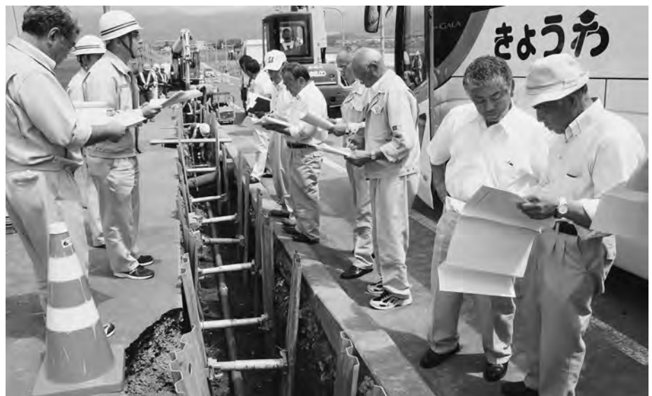
簡易水道 給水区域拡張 (大谷地地区) 現地調査
