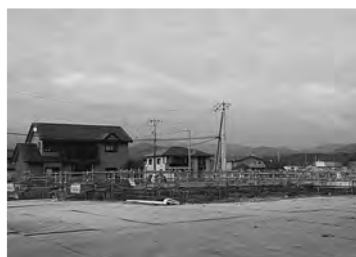
工事が進む 子育て支援センター
