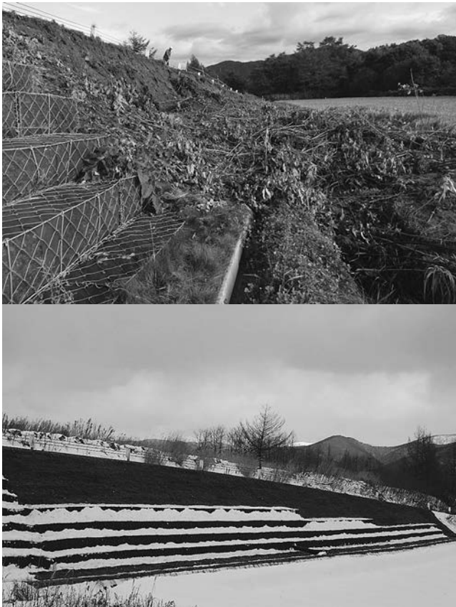
台風19号の大雨で法面が一部崩落した町道発足中央第一線 (写真上) 昨年9月の大雨直後 (写真下) 昨年12月の復旧工事後
